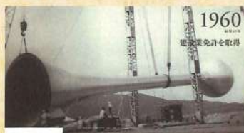
巨大な給水塔の据付工事
